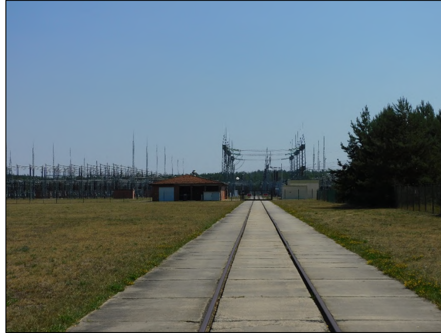
Bild 30: Blick Richtung Umspannwerk Graustein UG Abbau
