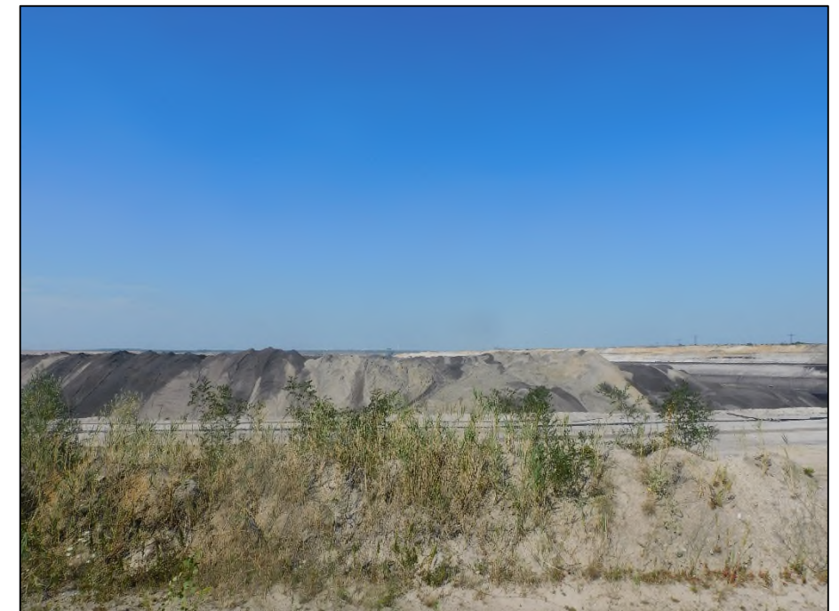
Bild 18: Tagebau Welzow-Süd, Blick vom Aussichtspunkt
