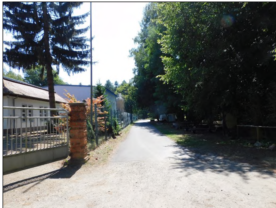
Bild 10: Blick Richtung Süden mit Naturschutzzentrum und Wasserwerk, UG Tagesanlagen und Mineralstoffverwahrung
